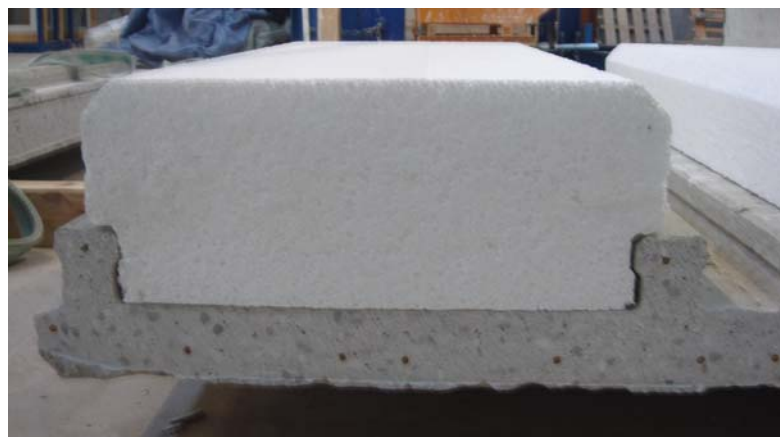
Foto 1: Sección de prelosa con bovedilla
