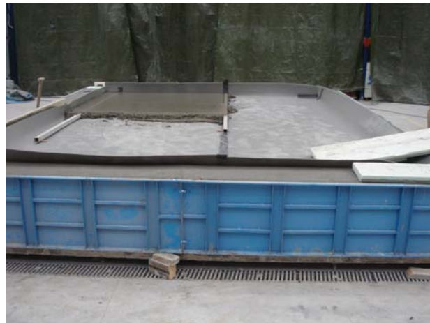
Foto 12: Vertido de losa de mortero
