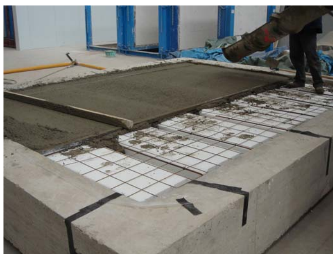
Foto 9: Vertido de hormigón
