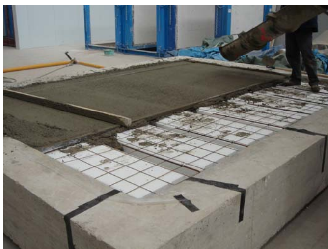
Foto 9: Vertido de hormigón
