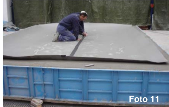
Fotos 10 y 11: Colocación de lámina de polietileno
