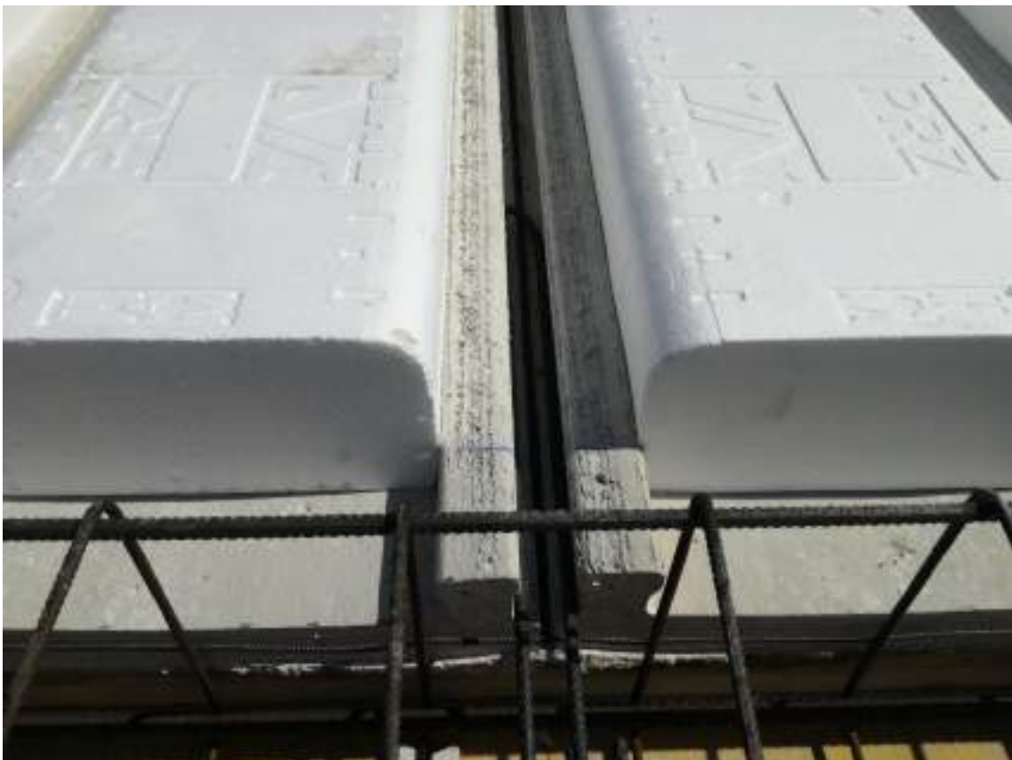
Ilustración 3 Junta de construcción prelosa PRZ vna
