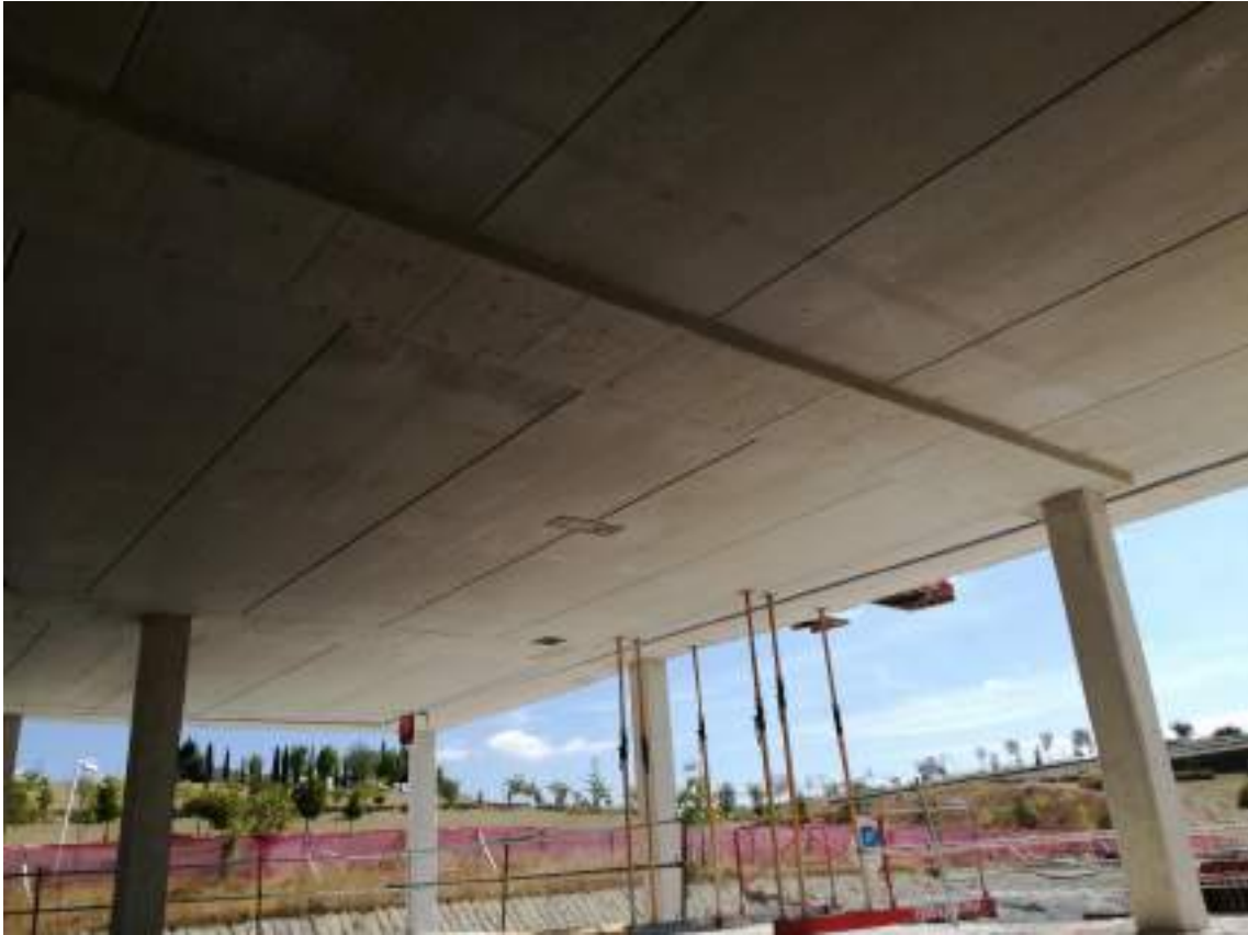
Ilustración 2 Prelosas instaladas con juntas vistas
